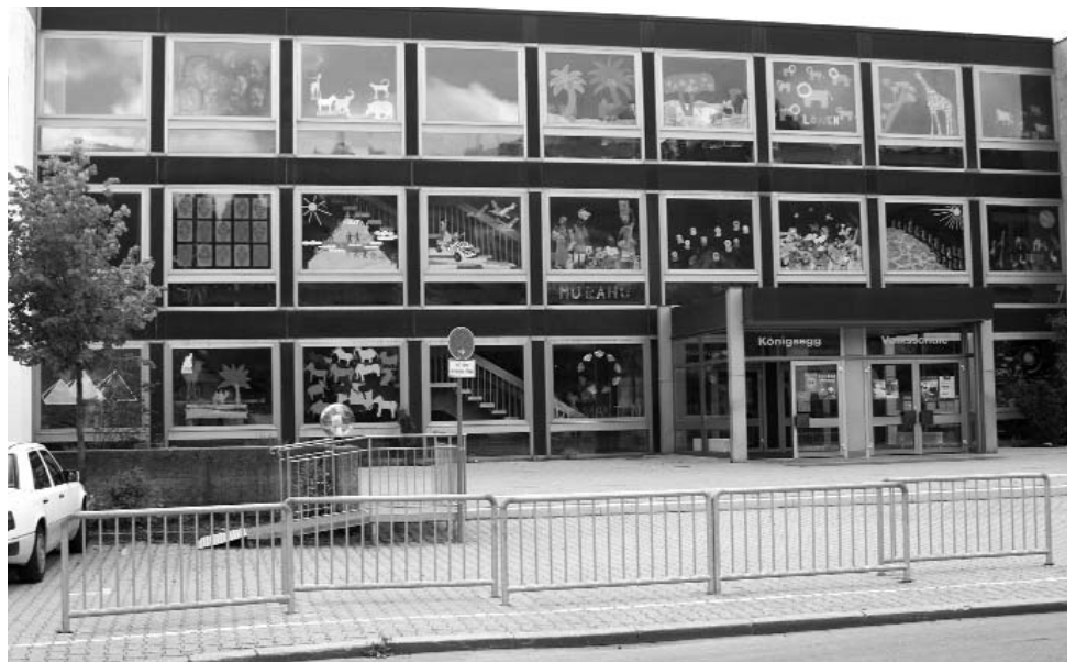
Die Königsegg-Grundschule ist in einem energetisch und baulich bedenklichen Zustand. Die Sanierung wird viel Geld kosten - besser ist dagegen die Situation an in den Kindergärten (Foto unten: Kindergarten Stein)
