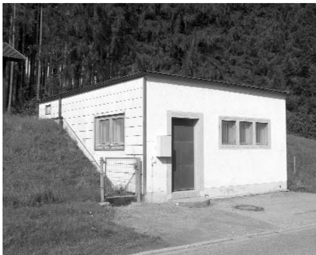
Versorgung der Bergstätte über den Hochbehälter bei Bräunlings
